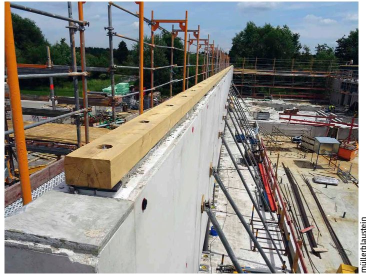
Eine Setzschwelle (hier noch ohne Futterholz) dient als Auflager für die Holz-Rippen-Elemente in den Außenwandachsen.
