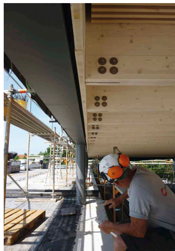
Untersicht der montierten Rippenplatten mit eingeschlitzten Blechen und Passbolzen an den Stahlträger mit Hilfe der Lagerschwelle.
