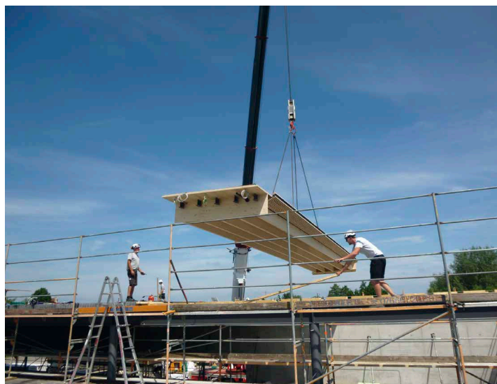
Einheben einer 3 m breiten Rippen-Platte
